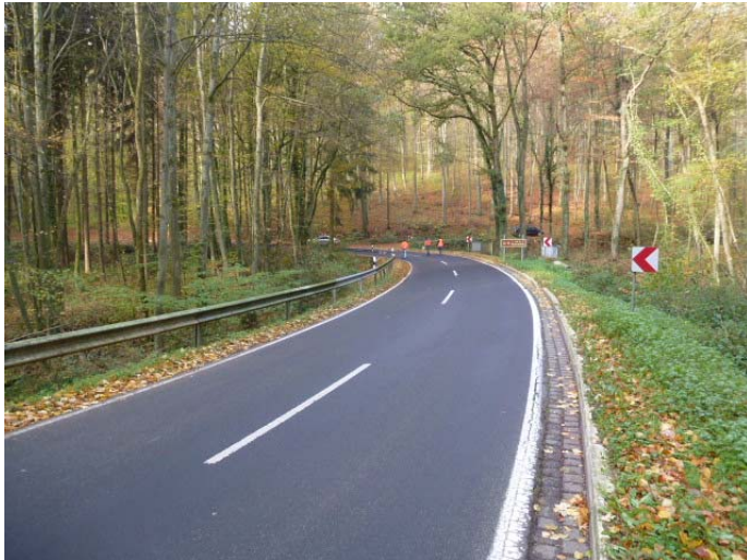
Brückenbauwerk aus südlicher Richtung
